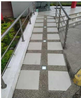
Repotenciación de luminaria modelo dicróico para piso
