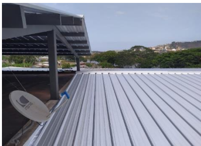
Implementación de cubierta en el área de la terraza
