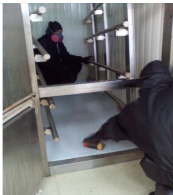
Reforzamiento de pisos de cámaras frigoríficas de no contaminados
