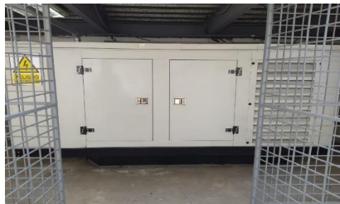
Puesta en marcha del generador eléctrico
