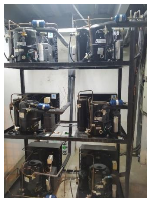
Puesta en marcha de las cámaras frigoríficas
