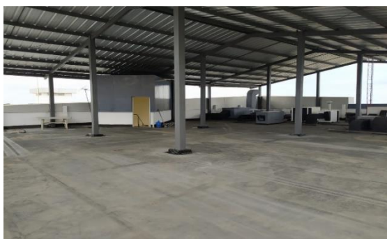
Implementación de cubierta en el área de la terraza
